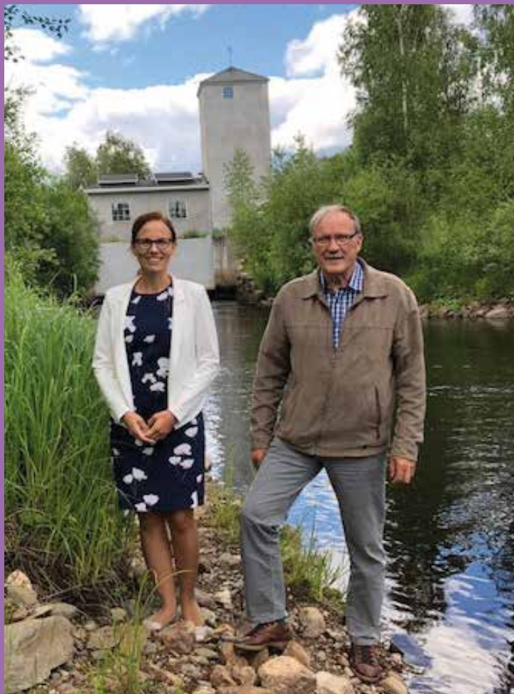
Kuvassa Pirttikosken vesivoimalaitos katselmuksella toimitusjohtaja Anu Rantala ja hallituksen puheenjohtaja Eero Johde
